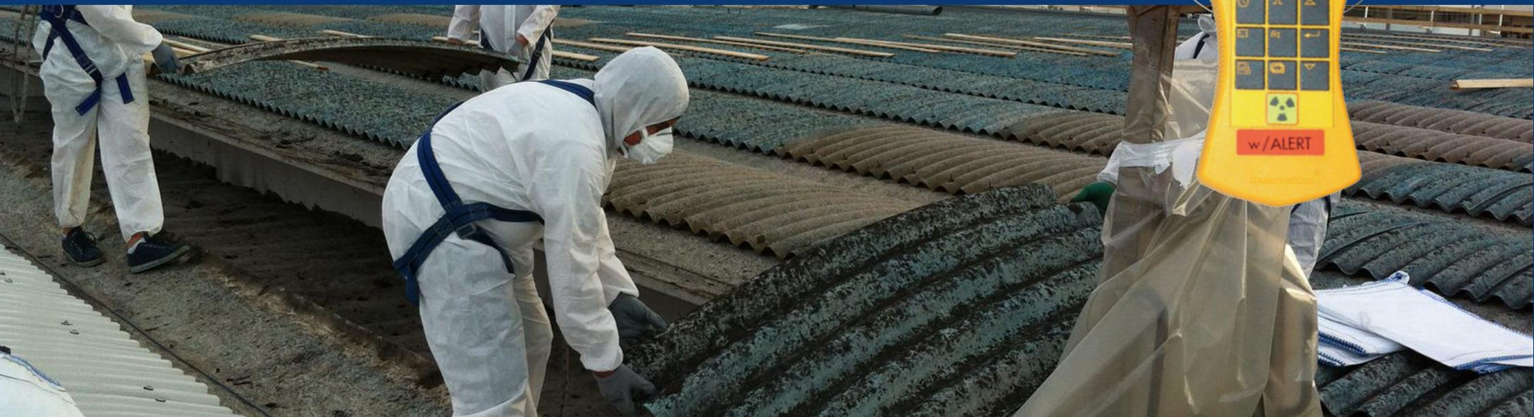
La rimozione e lo smaltimento di materiale pericoloso, quale l'amianto, comporta l'attuazione di rigide e controllate procedure per la salvaguardia e la protezione della salute dei lavoratori.
